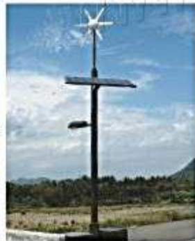
彰化嶼氣象站20kW風力太陽光電混用系統
