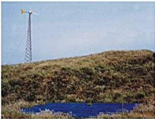
彰化嶼氣象站20kW風力太陽光電混用系統
